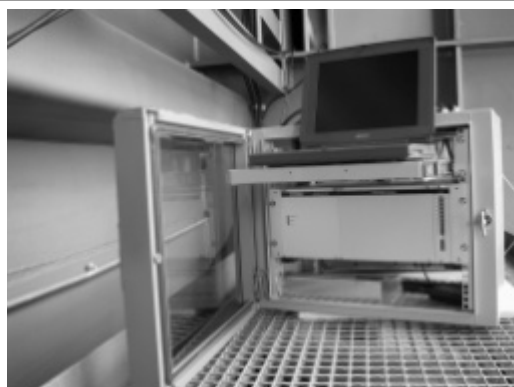
Bild 12: Multiplexer im Betrieb (Autolog / Peekel Instruments)
